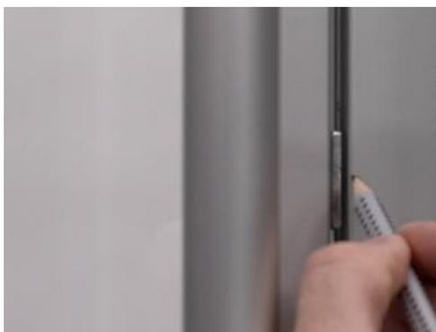
Die Position der befestigten Magnetplatte wird am gegenüber liegendem Profil angezeichnet.
