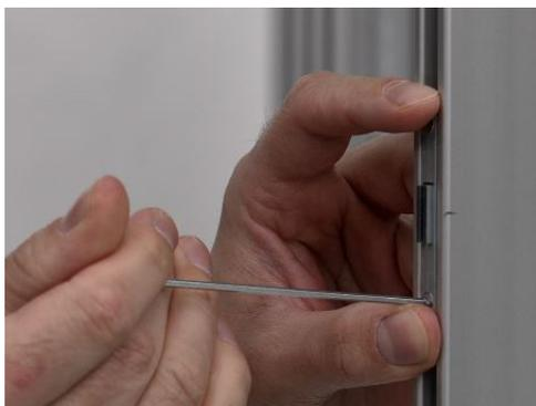
An der Markierung wird anschließend der Magnet in der Profilnut befestigt.
