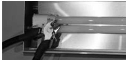
4. Beim ersten Leuchtmittelwechsel muss ein Kabelbinder durchtrennt werden. Dieser Kabelbinder dient als Transportsicherung und muss nicht erneuert werden. Sollte ein weiterer, späterer Transport durchgeführt werden, empfehlen wir die Transportsicherung zu erneuern.
