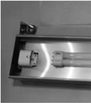
Das neue Leuchtmittel, Artikel 0.0.648.15 Kompaktleuchtstoffröhre 36W, kann anschließend eingesetzt und in der Fassung verrastet werden. Die Federklammer zur Fixierung wieder einsetzen und verrasten. Die Streuscheibe in den dafür vorgesehenen Spalt im Aluminiumgehäuse einschieben und die Seitendeckel an der Leuchte wieder sicher verschrauben.
