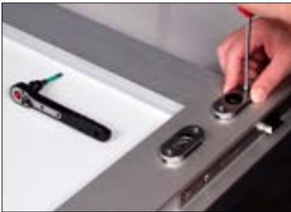
Die Abdeckungen für den Schließzylinder und die Türgarnitur werden beidseitig befestigt. Mit einem Schraubendreher TX25 handfest anziehen und ausrichten.
