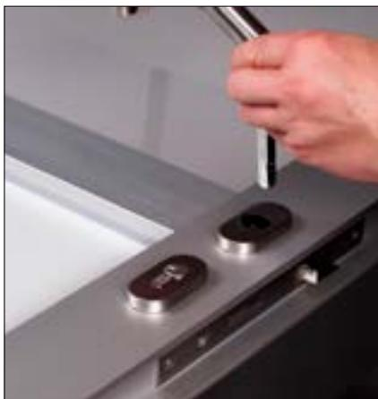
Ist die Funktionalität der Türdrückergarnitur gewährleistet, werden beiseitig die Rosetten-Blenden aufgeklippt und der Türdrücker wieder entfernt, da er bei der weiteren Türmontage hinderlich ist und beschädigt werden könnte.
