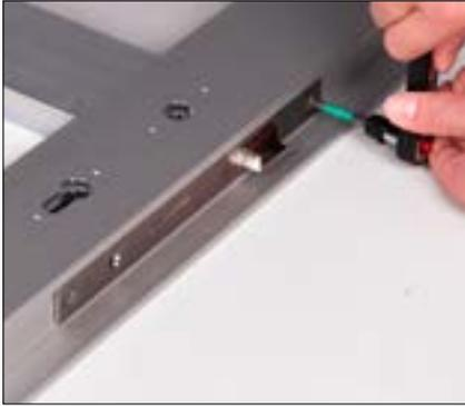
Das Einsteckschloss wird anschließend in die Ausfräsung des Türprofils eingeschoben und mit einem Schraubendreher TX25 vorsichtig handfest angezogen.
