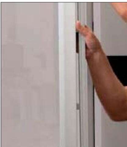
Zuerst werden die vertikalen Zargenprofile mit der Hand in ein Rahmenprofil der Baureihe 8, der Grundkonstruktion, gedrückt.
