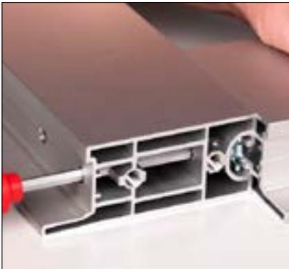
Das untere und obere horizontale Türprofil **11** der Durchgangstür wird ebenfalls vorsichtig in die Nut 8 des vertikal angeordneten Türprofils eingeschoben.
