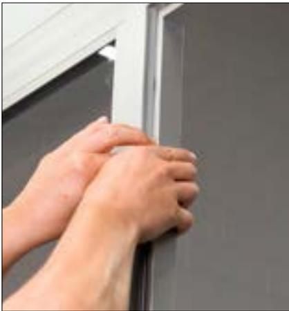
Im nächsten Schritt wird die Zargenprofil-Dichtung 10x4,8 in das Zargenprofil 8 31x20 **15** gedrückt. Dieses Dichtungsprofil kann, nach Vorgabe auf Länge geschnitten, trocken verbaut werden. Durch einen integrierten Draht weist die Zargenprofil-Dichtung keine Dehnungs- oder Schrumpfungseigenschaften auf.
